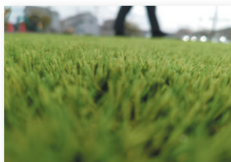
人工芝設置施工
